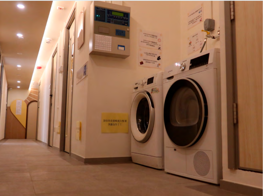
“匠心园”红磡过渡性房屋项目
